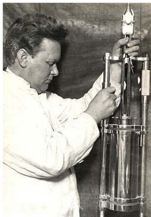
Figur 9. Instrumentmager og konservator Hans Jørgen Nielsen fremstiller en Knudsen-isolerende vandhenter. Foto fra ca. 1920.
