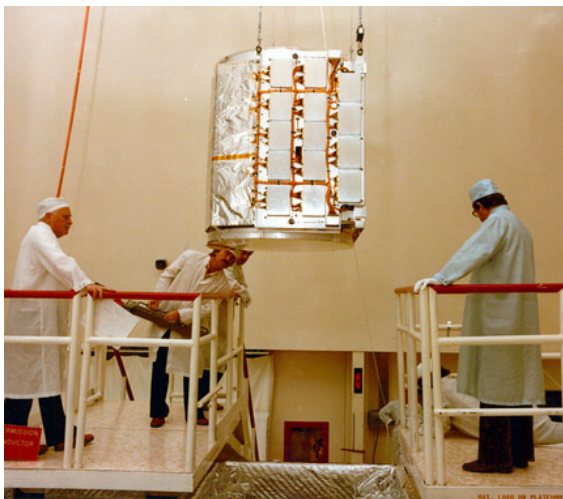
Figur 6. Dansk-fransk kosmisk strålings-instrument monteres i HEAO satellitten, Californien 1978.
